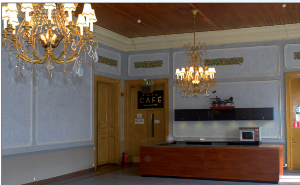
Ravintolasalin katosta poistettiin vanhat "pinkopahvit" ja alta löytynyt helmiponttipaneli jätettiin kattoon. Katon kristallikruunut kunnostettiin ja tarjoilutiski uusittiin.
