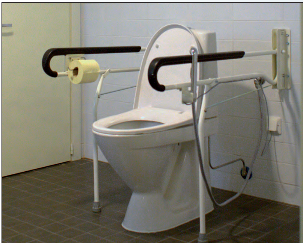
Remontin yhteydessä alakerran vaateaulaan rakennettiin uusi inva-WC.
